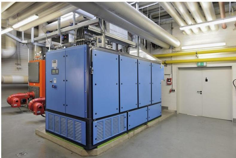
**Bild 3:** Neben dem Umstieg auf Ökostrom investiert Hörmann in weitere, nachhaltige Maßnahmen. Ein Teil des Wärmebedarfs wird aus der Abwärme von eigenen Blockheizkraftwerken abgedeckt. Biogas Blockheizkraftwerke sind in Planung.
